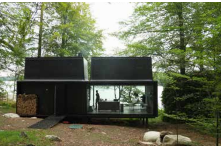
▲ Fritidshus nedställt i terrängen på plintar utan större inverkan på omgivande mark. Fasadens dova ton är lugn i miljön. (Foto: Nicolas Boullosa)
