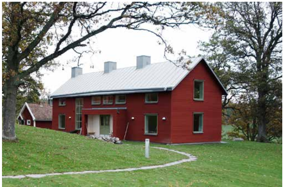
► Villa i Bleckstad. Traditionella former med modernt uttryck i farstu, fönster m.m. Arkitekt: Fredriksson Arkitektkontor.
