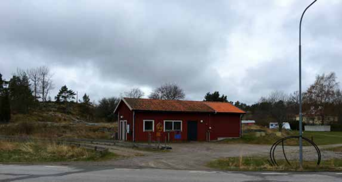
◀ Befintligt vatten- och avloppsverk vid Tyrislöts hamn.
