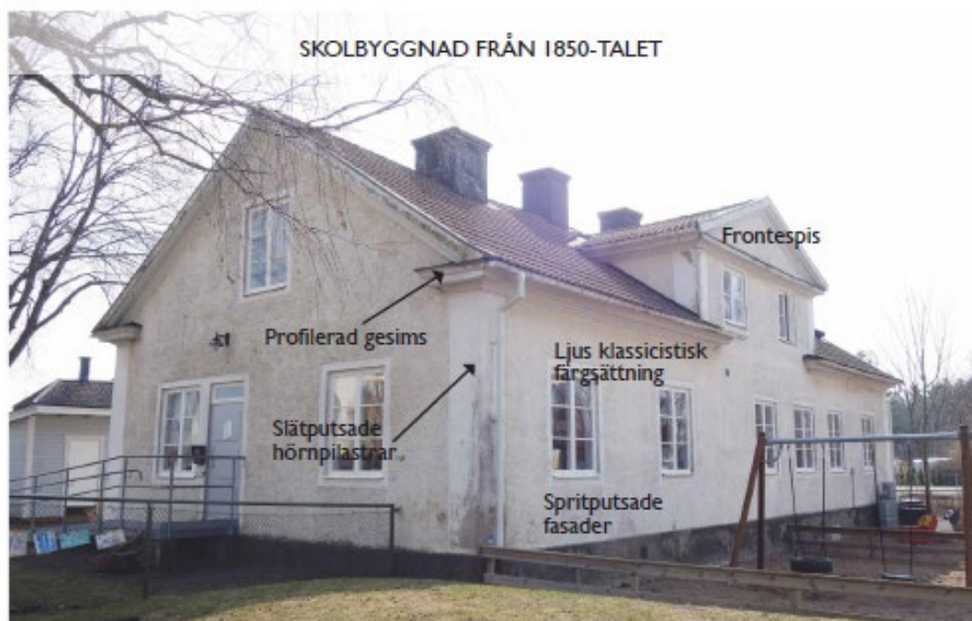
Figur 7: Fotografi visar skolbyggnaden från 1850-talets baksida och byggnadens kulturhistoriska och arkitektoniska drag som är tidstypiska för byggnaden (Foto: Fredrikssons Arkitektkontor, 2023).
