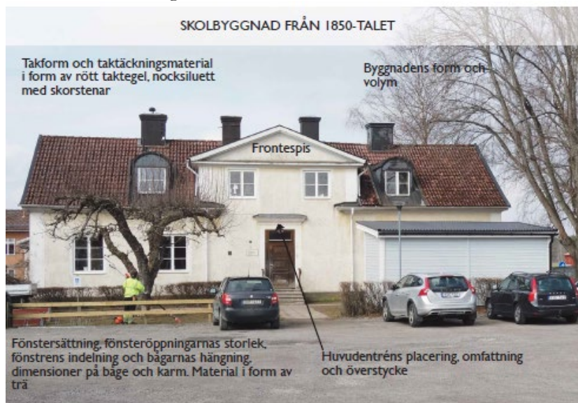
Figur 6: Fotografi från framsidan av skolbyggnad från 1850-talet. Fotot visar på de kulturhistoriska och arkitektoniska drag som är tidstypiska för byggnaden (Foto: Fredrikssons Arkitektkontor, 2023).
