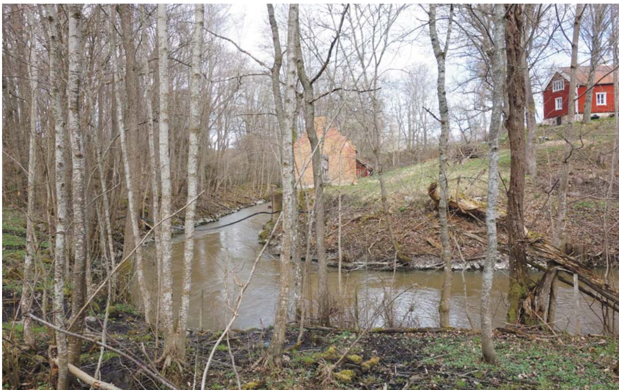
På andra sidan än från kvarnlämningen finns ett tidigare kraftverk uppförd i tegel med karaktäriserande trappgavlar. Till höger i bild skymtar det rödfärgade bostadshuset.
