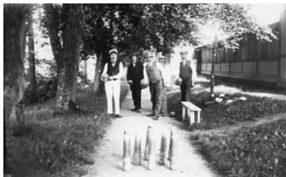
Kägelbanan (byggnaden till höger i bild) på platsen för nuvarande pensionärsbostäder ”Vimman”.
