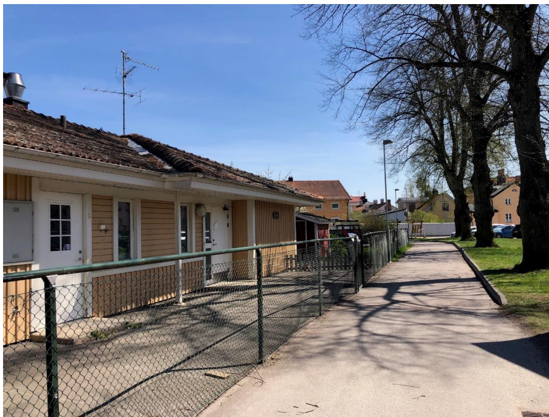
Figur 10. Förutom gatubelysningen finns också fasadbelysning på förskolan i anslutning till trädraden, vilket syns vid dörren i bildens mitt.
