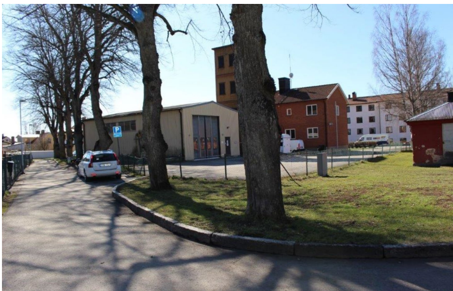
Figur 28 Gamla Brandstationen från Järnvägspromenaden. Slangtornet skymtas bakom trädet. Till höger i bilden visas komplementbyggnaden som står inom parkmarken. Källa: Emilia Borgarello 2021-04-21
