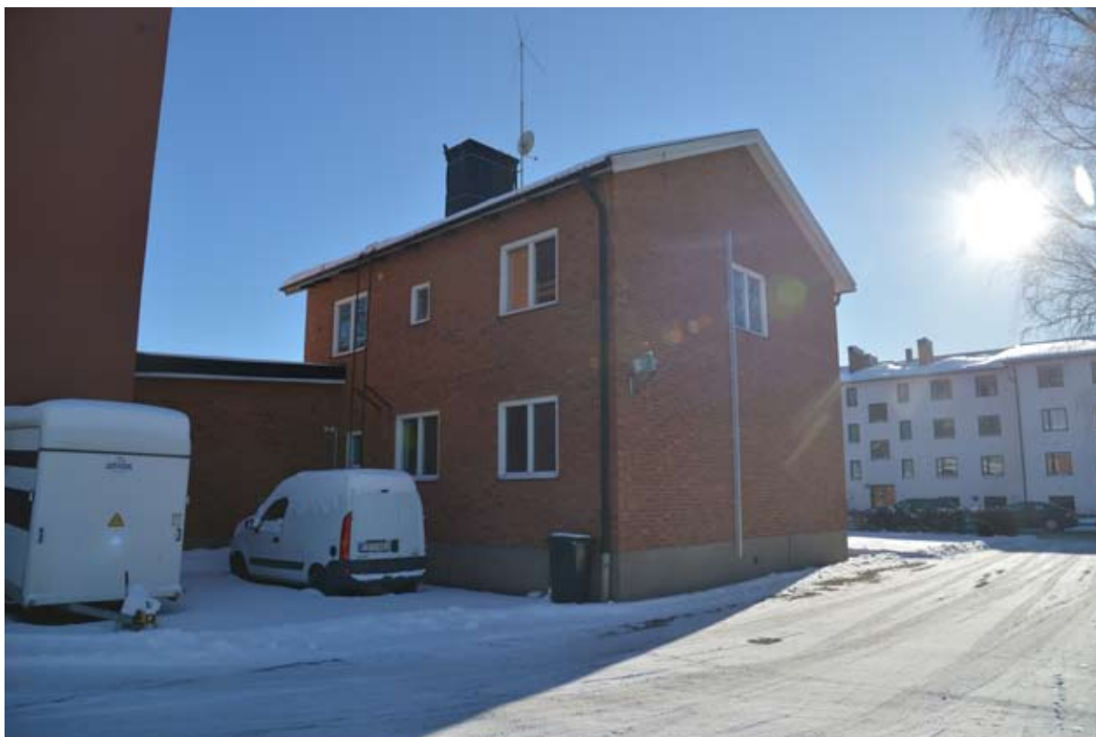
Huvudbyggnaden från norr.
