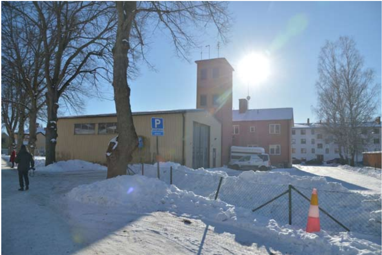
Byggnadskomplexet från norr, närmast i bild vagnhallstillbyggnaden från 1980-talet, bakom denna slangtornets norrfasad med utfackningsväggar i trä, bakom tornet huvudbyggnaden.
