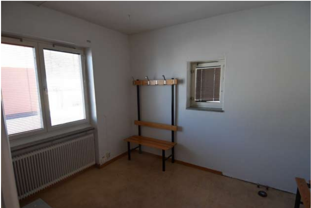
Rum på övervåningen i den tidigare bostadslägenheten. Fönster samt sektionsradiator är ursprungliga, medan övrigt är av senare datum.
