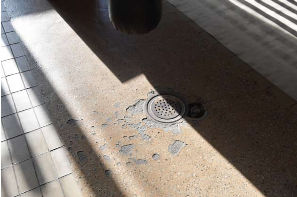
Ursprunglig golvbrunn i vagnhallen.
