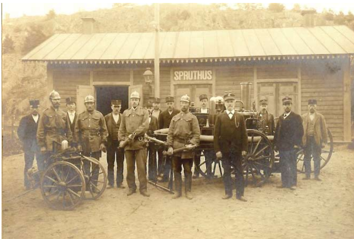
Söderköpings brandkår fotograferad av Carl Sundberg 1902. "Spruthuset" låg då i kvarteret Gästgivaren, intill stadshotellet. Bild S:ta Ragnhilds Gille B0001
