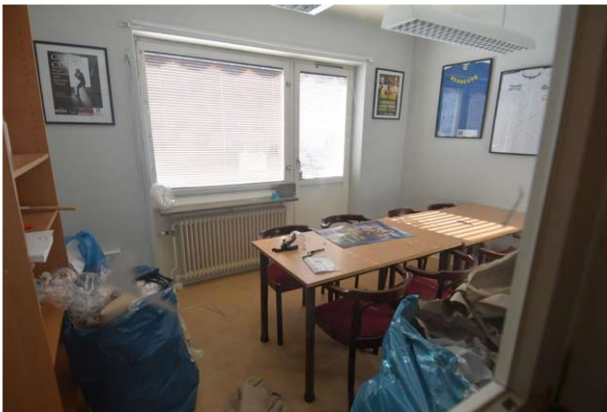
Mötesrum på bottenvåningen. Glasparti med balkongdörr till gatufasadens franska balkong samt ursprunglig sektionsradiator.
