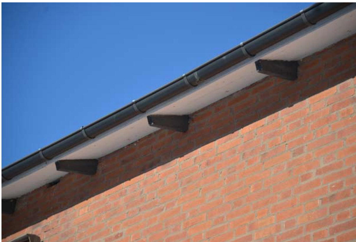
Takfotsdetalj på huvudbyggnaden. Takfoten är mycket typisk för 1950-talets byggnasskick.
