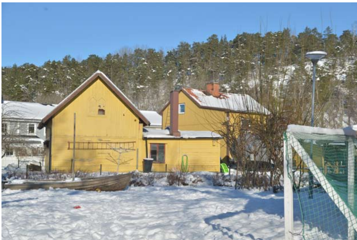
Förskolans gård och rester av äldre bebyggelse i kvarterets norra del, mot Bergsgatan.
