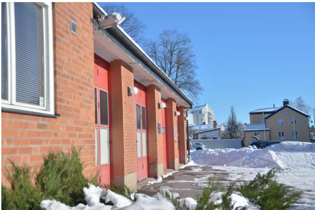
Vagnhallens fasad med bytta portar.
