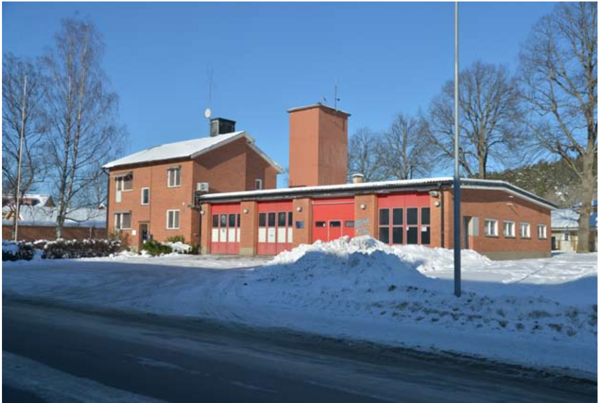
Brandstationen från sydöst. Byggnaden har en närmast emblematis brandstationskaraktär med vagnhall, huvudbyggnad och slangtorn.
