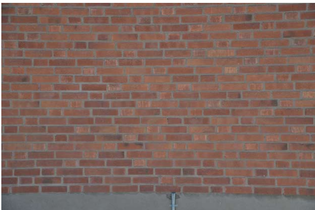
Fasadparti med tegelmur i munkförband. Fasaderna är utförda i håltegel.
