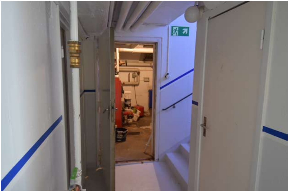
'Trapphuset i källarvåningen. Interiören bevarar flera ursprungliga detaljer som dörrar, lister och foder, samt armaturer och installationer.
