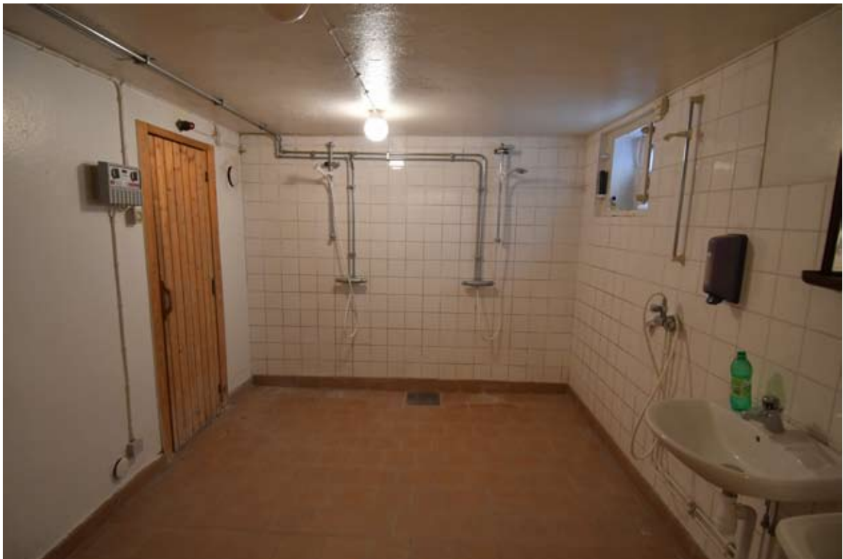
Duschru i källaren med sekundära ytskikt av sent datum.
