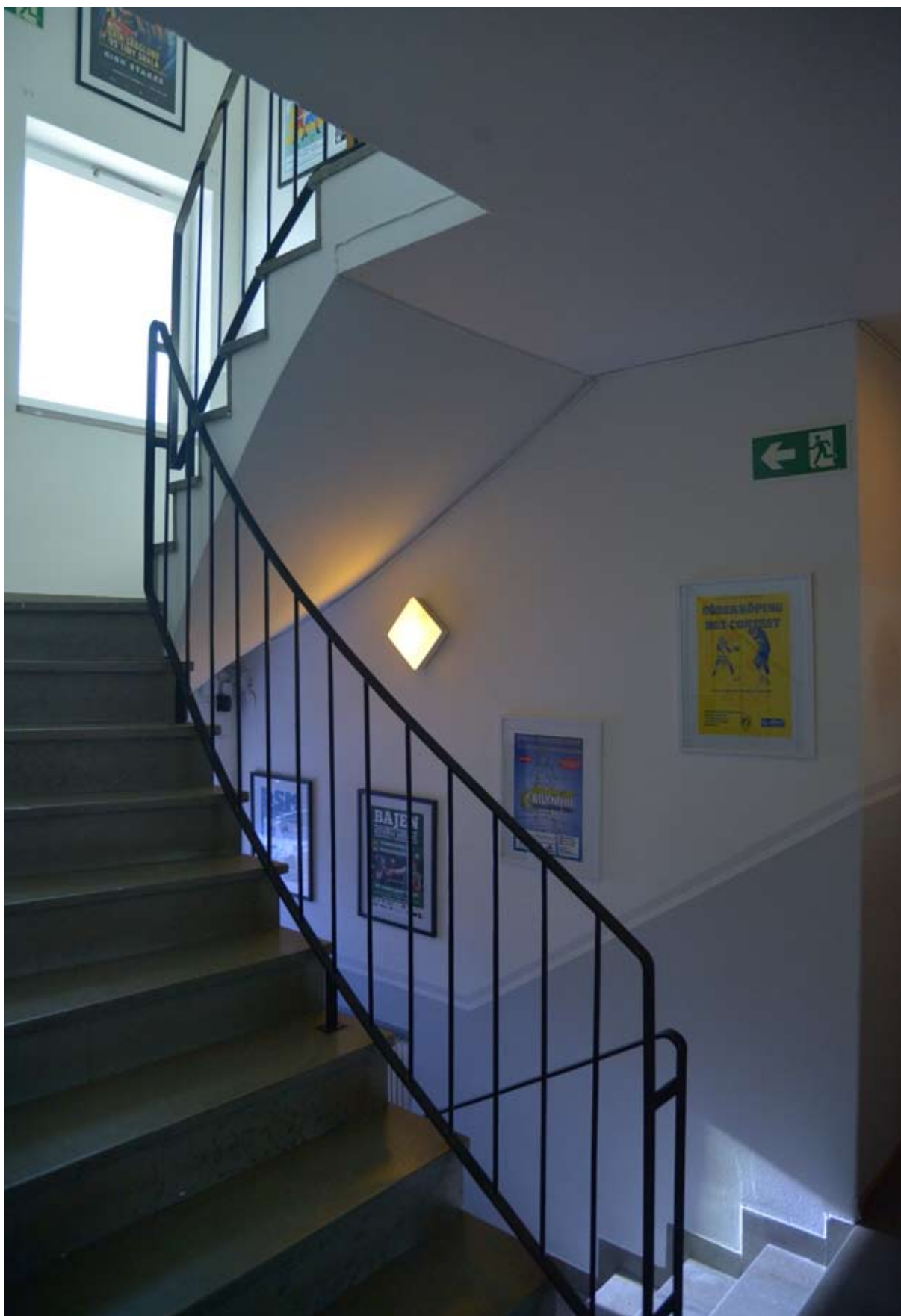
Trapphuset där såväl golv som plansteg, sättsteg och socklar är i kalksten. Smidesräcke i saklig funkis.
