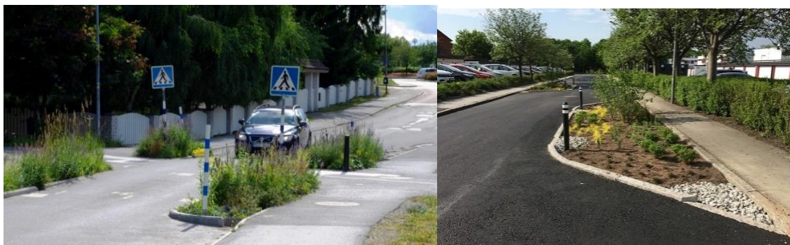
Figur 12) Exempel på växtbäddar för omhändertagande av dagvatten i gatumiljö. Bilder hämtade från dagvattenguiden.se .
