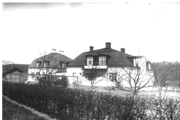
Baksidan mot järnvägen och senare riksvägen.
