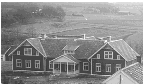
Det gamla arbetshemmet. Bilden beskuren. Tillhör Sankt Ragnhilds Gille.
