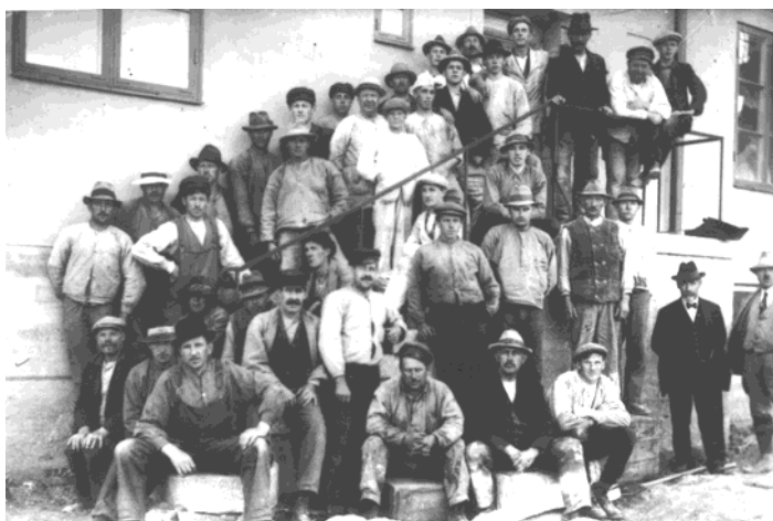
Ett arbetslag vid bygget av Storängen på trappan till kyrksalen, A-huset. Bl. a. Axel Furéh, Nartorp, senare maskinist vid Brunnen, Ernst Karlsson, Dolmar Karlsson, Erik Pettersson, Murare Karl Lund, Byggmästare Gustavsson, Haddebo, Kontrollant Malmberg, Finspång, Snickare Karl Nyberg, Hällorna, Bruno Berling, Herbert Berling, Elof Berling, Allan Berling. Bilden tillhör Sankt Ragnhilds Gille.
