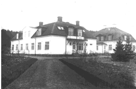
Framsidan med entrén från landsvägen till Linköping. Numera Linköpingsgatan.
