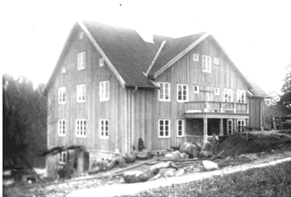
Hammarspångens ålderdomshem under uppbyggnad.
