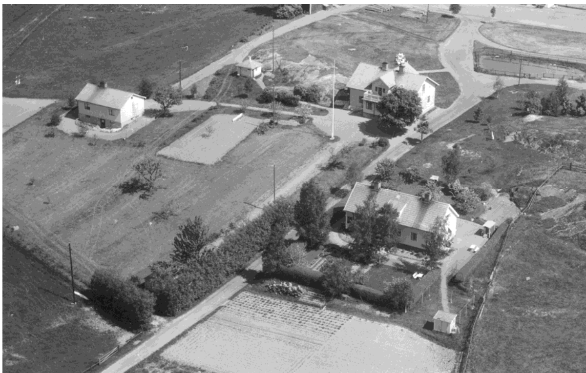
Uppe till höger ligger mangårdsbyggnaden. Nere till höger personalbostaden från 1937 och till vänster den från 1942. Flygfoto från 1950-talet. Privat bild.
