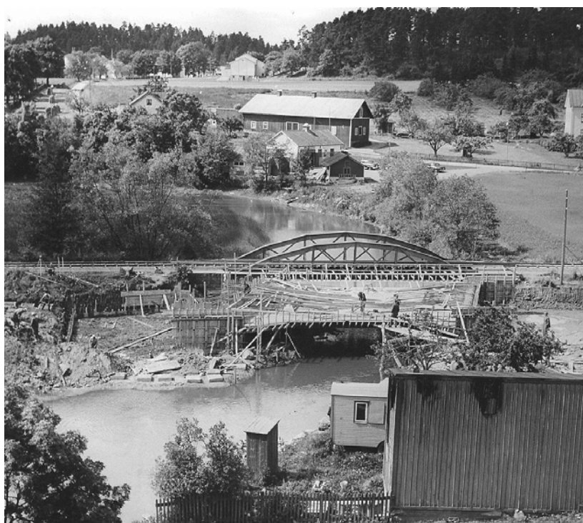
Arbetet med att bredvid järnvägsbron bygga en ny landsvägsbro över Storån för den nya genomfartsleden på 1960-talet. Då revs även en ekonomibyggnad till epidemisjukhuset. Järnvägen lades ner 1966. Genomfartsleden hette E15 fram till 1980 då den blev E66 och från 1992 och fortfarande heter den E22. Den del som går genom Söderköping kallas även Erik Dahlbergsgatan. Bilden tillhör Söderköpingsbornas egna bilder. Stinsen Söderköping.
